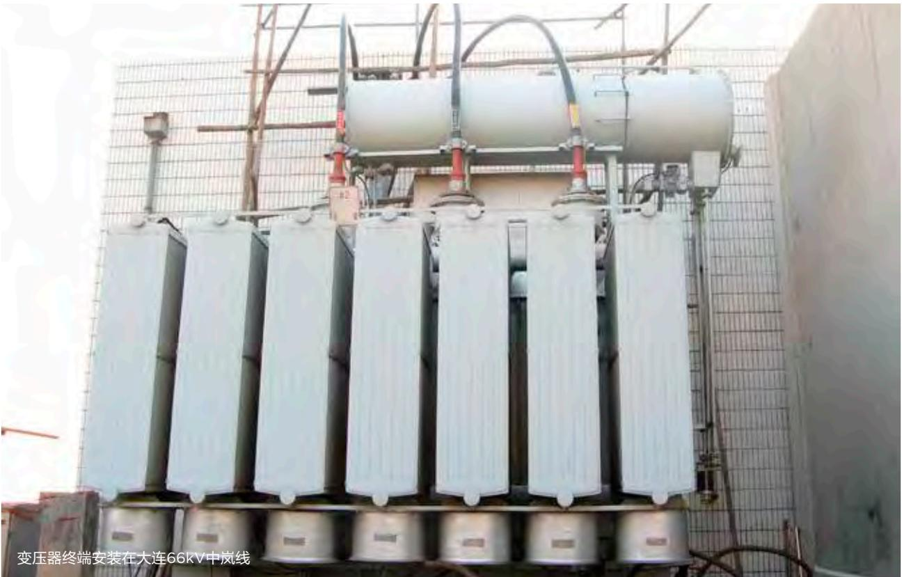
变压器终端安装在大连66kV中岚线
