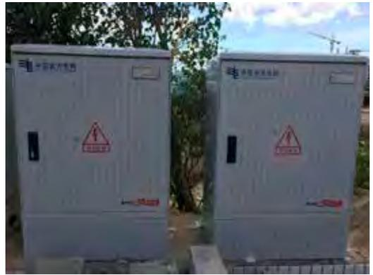
中间接头及接地箱安装在南网珠海琴韵-澳门220kV线路
